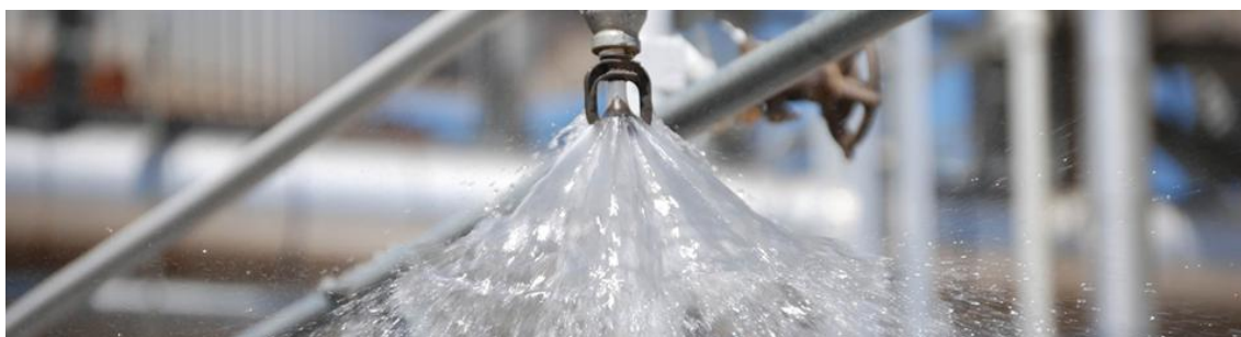
Figura 5: Teste molhado do dilúvio
