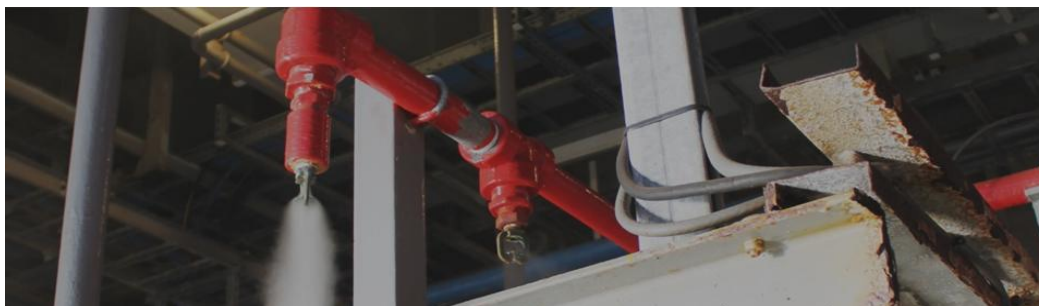
Figura 7: Teste de dilúvio a seco, utilizando fluido gasoso.
